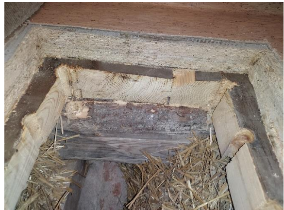
TV8, välipohjan rakenneavaus
