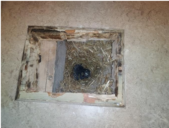
TV4, välipohjan rakenneavaus. Eristeenä hiekkaa ja olkea.
