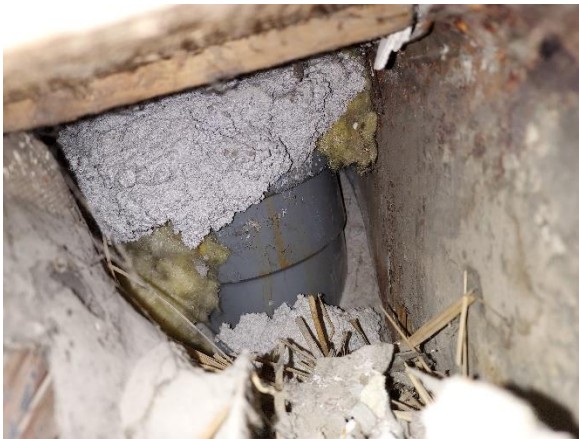
TV2, rakenteessa kuivuneita kosteusjälkiä ja vanha viemäripiste.
