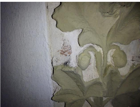
Julkisivujen pystymalliset koristeet varmistettava kiinnityksen osalta, koristeet pitivät kopisevaa ääntä.
