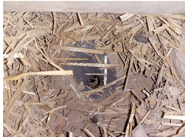
TV2, rakenteessa kuivuneita kosteusjälkiä ja vanha viemäripiste.
