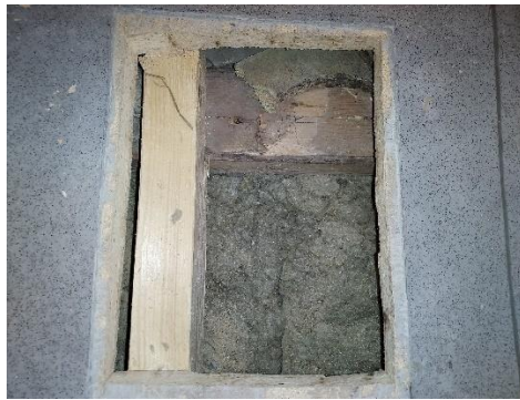
TV7, välipohjan rakenneavaus
