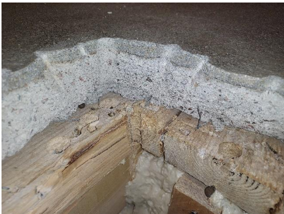
TV9, välipohjan rakenneavaus
