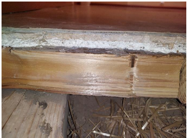
TV5 välipohjan rakenneavaus. Pintarakenteissa useita eri aine-kerroksia.
