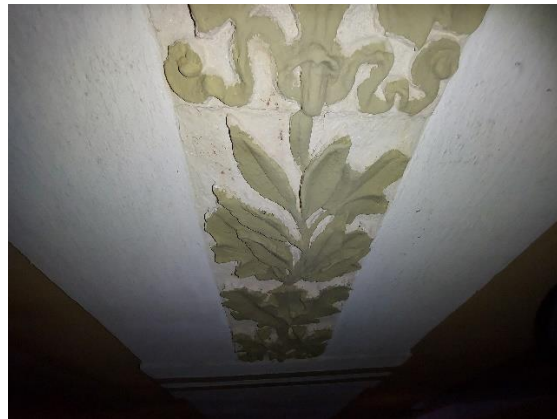
Julkisivujen pystymalliset koristeet varmistettava kiinnityksen osalta, koristeet pitivät kopisevaa ääntä.
