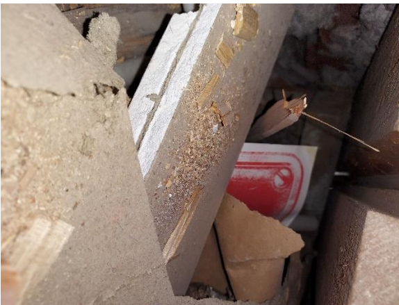
TV6, välipohjan rakenneavaus. Välipohja täytetty rakennusjätteillä eristemateriaalin sijasta.
