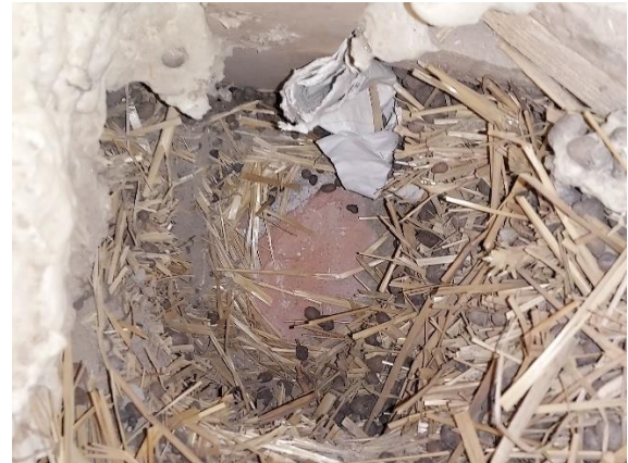
TV9, välipohjan rakenneavaus
