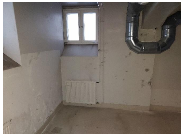
Kellarikerroksessa ikkunat ja ovet altistuvat karmien taustapintojen osalta perusmuureissa esiintyvälle maaperäkosteudella ja karmien yleiskuntoa ei pysty luotettavasti määrittämään ilman paikaltaan irrottamista.
