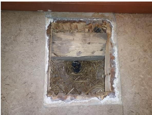
TV5 välipohjan rakenneavaus. Pintarakenteissa useita eri aine-kerroksia.
