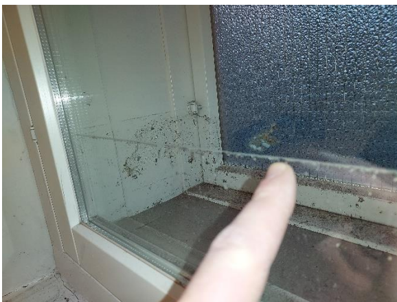
Kellarikerroksessa ikkunat ja ovet altistuvat karmien taustapintojen osalta perusmuureissa esiintyvälle maaperäkosteudella ja karmien yleiskuntoa ei pysty luotettavasti määrittämään ilman paikaltaan irrottamista.
