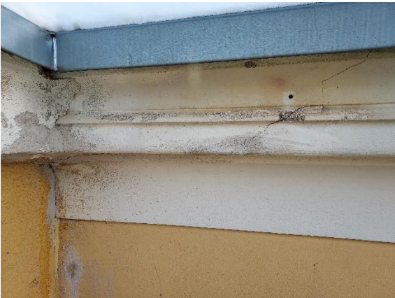
Räystäissä pitkälle edenneitä vaurioita sadevesien syöksytörvien ja vesikaton rajapintojen läheisyydessä
