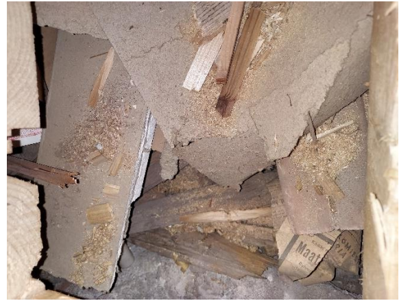
TV6, välipohjan rakenneavaus. Välipohja täytetty rakennusjätteillä eristemateriaalin sijasta.
