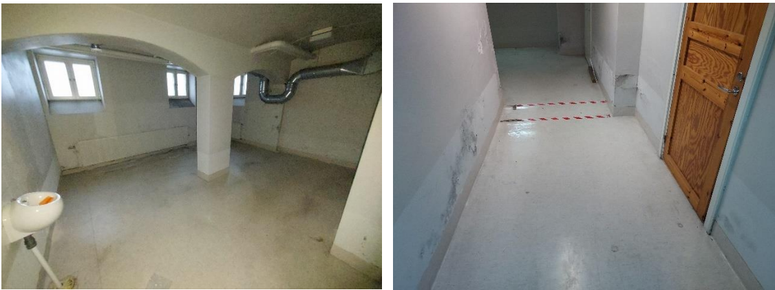
T3 ja T4 kohdalla alapohjan rakenteessa ilmaväli betonilaatan ja täyttöhiekan välissä
