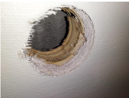
T3 ja T4 seinärakenne, 3.kerros
