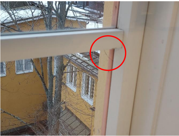
Ulompien ruutujen kulmissa havaittiin useammassa ikkunassa halkeamia
