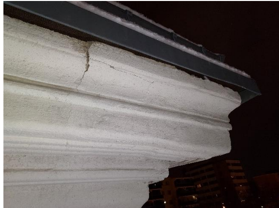
Räystäissä pitkälle edenneitä vaurioita sadevesien syöksytörvien ja vesikaton rajapintojen läheisyydessä
