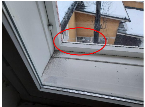
Ulompien ruutujen kulmissa havaittiin useammassa ikkunassa halkeamia
