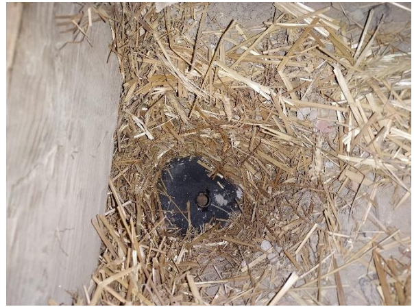
TV4, välipohjan rakenneavaus. Eristeenä hiekkaa ja olkea.
