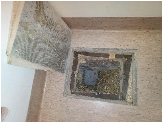
TV8, välipohjan rakenneavaus
